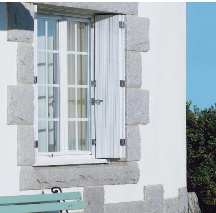
Lames aspect lisse de 14 mm d'épaisseur, formant 4 à 12 vantaux articulés entre eux. La fermeture est assurée par une espagnolette plate en aluminium et un loquet de fermeture ou serrure 3 points posée en option. Les accessoires sont zingués ou en inox 304.
